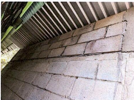
Foto 5: Reparación y Mejorameinto de paredes de cocina
