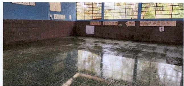
Foto 6: Mantenimiento de piso en aulas
