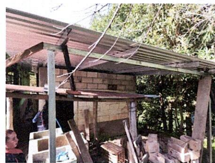
Foto 4: Mejorameinto de techo en área de cocina
