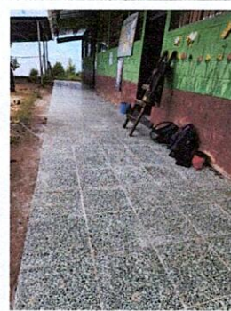
Foto 2: Mantenimiento piso corredor
