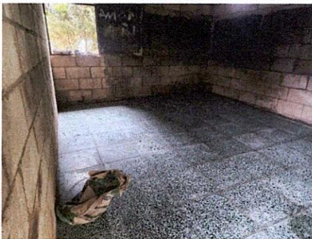
Foto 3: Reparacion y mejoramiento piso cocina
